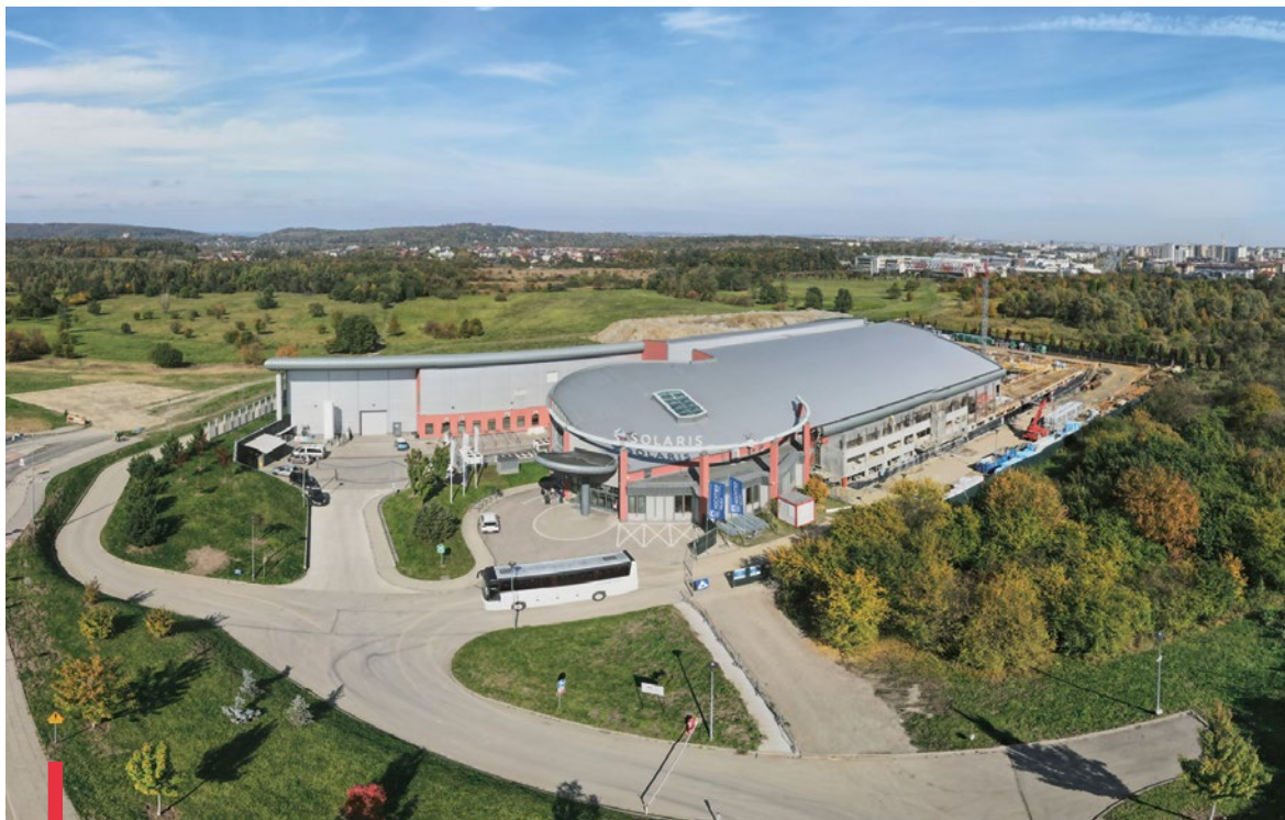
Zdjęcie 1. Zdjęcie budynku NCPS SOLARIS i trwającej rozbudowy hali eksperymentalnej.
