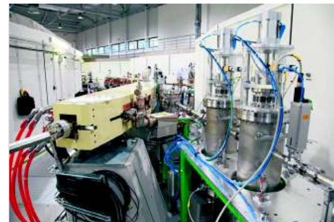
Widok tunelu pierścienia akumulacyjnego
