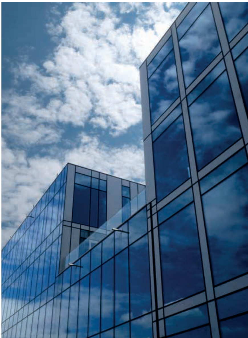
Obiekt przy ul. Medycznej w Krakowie powstały w oparciu o projekt autorstwa Tomasz Fudali Architektura & Consulting
