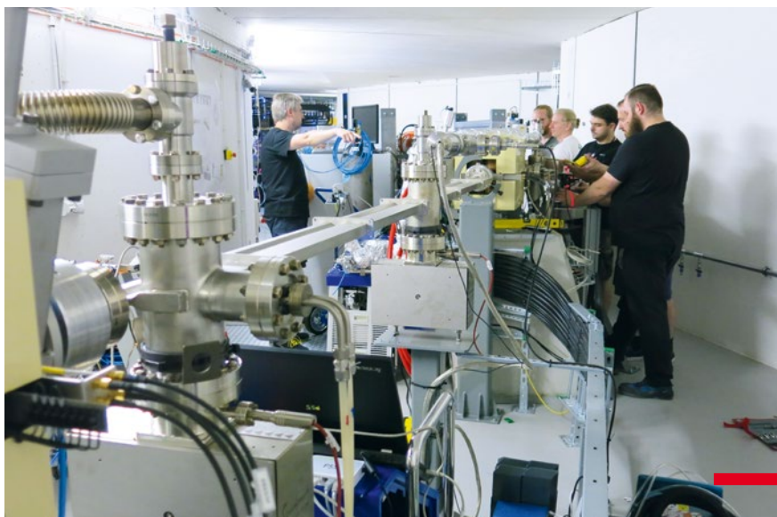
Instalacja linii diagnostycznej typu pinhole
