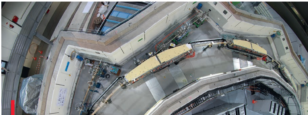
Widok odgórny na otwarty tunel akceleratora kołowego
